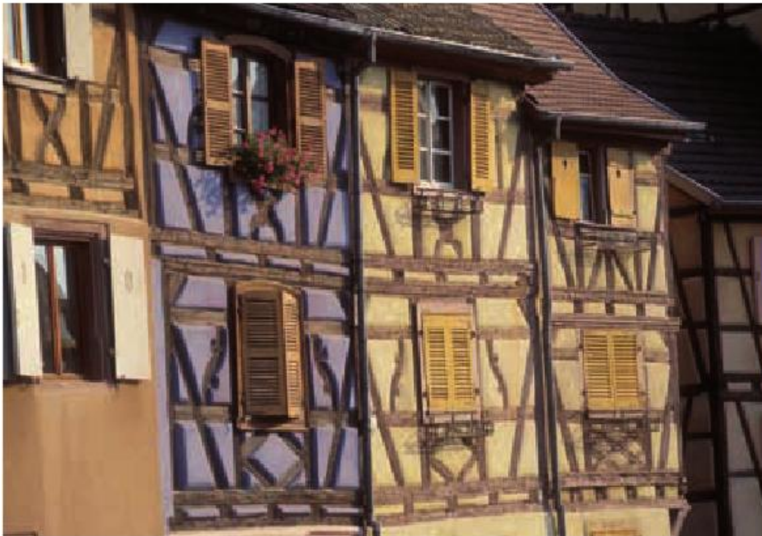
Construcciones antiguas en Colmar, Alsacia, Francia.
